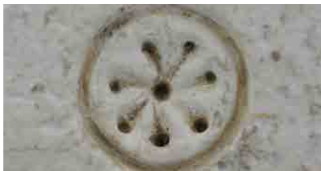
Şəkil 18. Hamamın döşəmə hissəsindəki su ötürücüsü / Qala ərazisi
