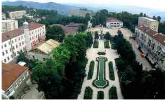
Şəkil 1. Şuşanın mərkəzi küçəsi. Sovet dövründə tikilmiş çoxmərtəbəli binalar
