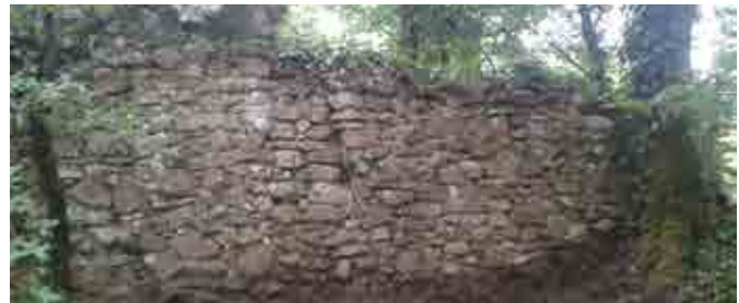
Şəkil 4. Zərnə qalasında müdafiə divarının qalığı
