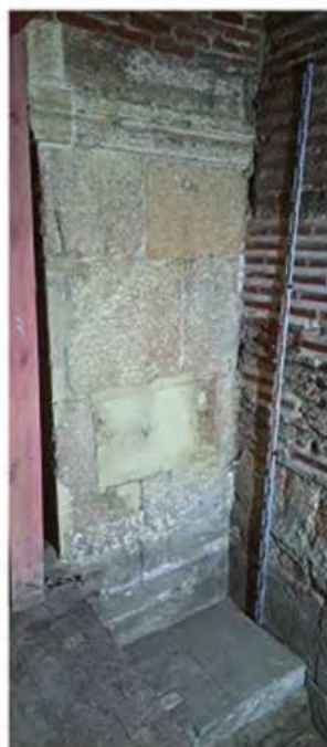
Рис. 6. Дербент. Джума-мечеть. Интерьер. Восточная стена. Примыкание пилястра к стене (1) и характер кирпичной кладки (2)
