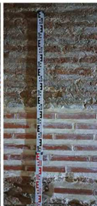
Рис. 6. Дербент. Джума-мечеть. Интерьер. Восточная стена. Примыкание пилястра к стене (1) и характер кирпичной кладки (2)
