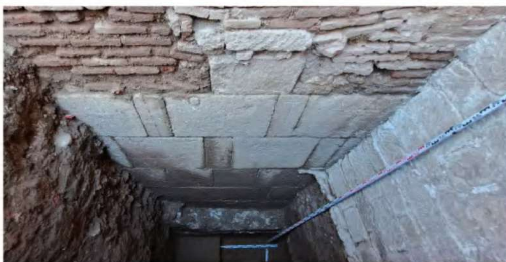
Şəkil 2. Dərbənd. Cümə məscidi. Cənub divarı. Şurf 46. Məscidin cənub divarının xarici fasadının sasanı kərpic və daş hörgü. CCŞ (Cənub–Cənub–şərq) tərəfdən görünüş
