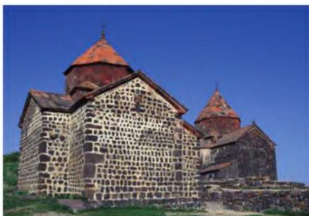
Şəkil 18. Sağ və soldakı kilsələrin divar hörgülərinə diqqət yetirin!
