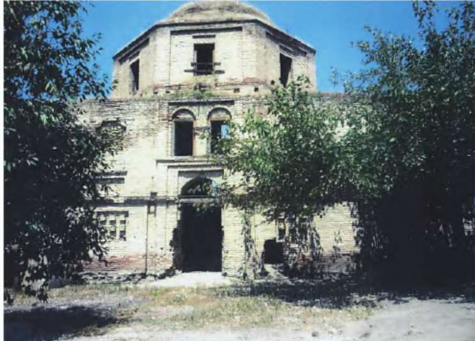
Şəkil 1. Xaçmaz məbədinin cənubdan görünüşü
