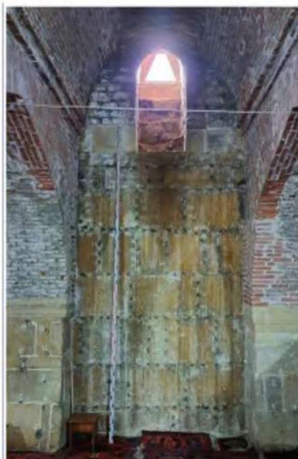
Şəkil 3. Dərbənd. Cümə məscidi. İnteryer. Cənub divarının daxili fasadı. ŞŞQ-dən (Şimal-Şimal-qərb) görünüş
