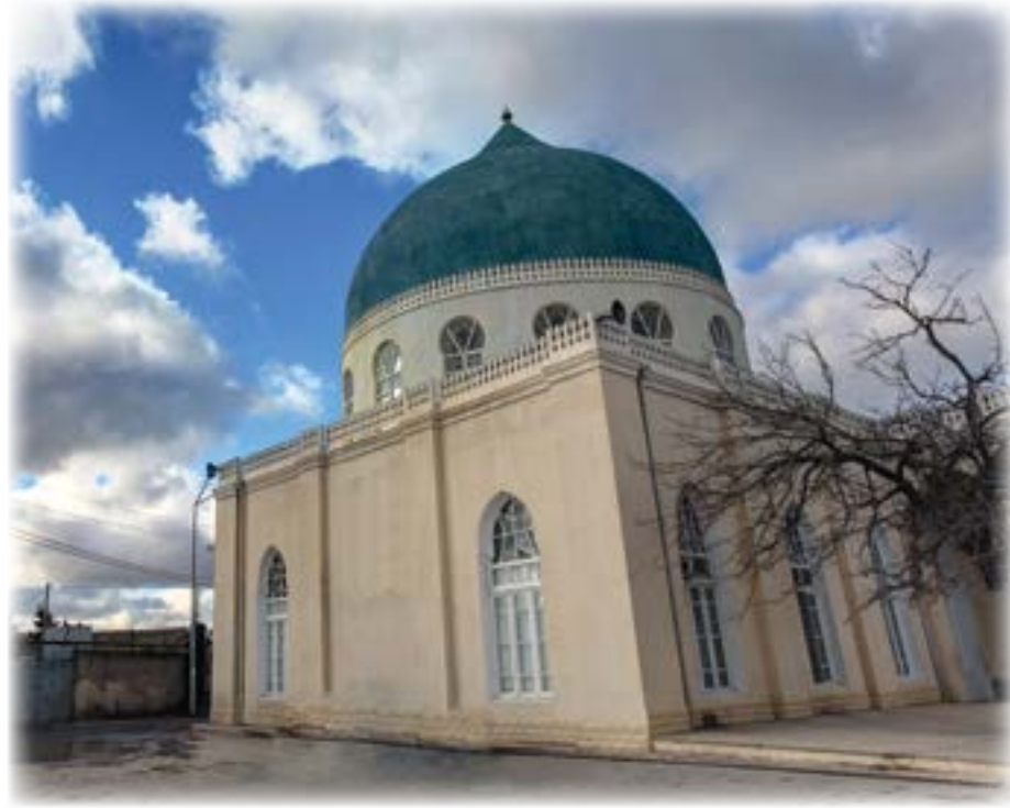
MÖHSÜN SƏLİM MƏSCİDİ (BAKİ ŞƏHƏRİ, XƏZƏR RAYONU, BİNƏ QƏSƏBƏSİ) MOHSUN SALIM MOSQUE (BAKU, KHAZAR DISTRICT, BINA SETTLEMENT) مسجد محسن سالم ( مدينة باكو، منطقة خزر، قسبة بينا )
